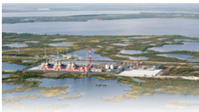
Ватьеганская ГТЭС на базе шести газотурбинных установок суммарной мощностью 72 МВт
