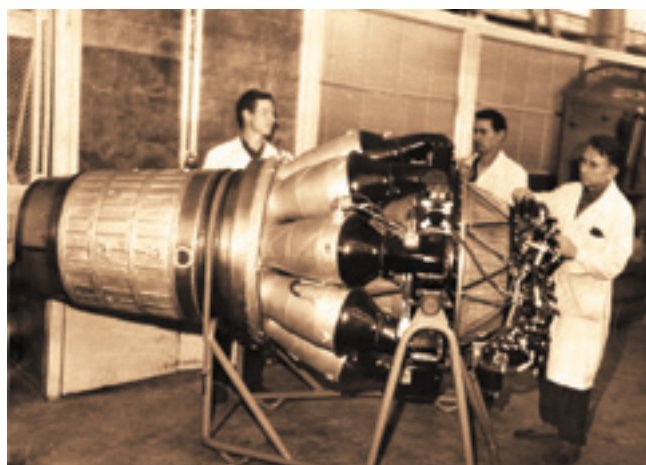
1949 г. Сборка реактивного двигателя ВК-1 конструктора В.Я. Климova. Устанавливался на реактивные истребители МиГ-15, МиГ-17, бомбардировщик Ил-28, опытный Ла-176
