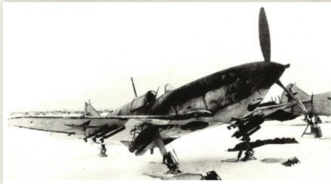
Серийный ЛаГГ-3 на лыжах. Под крылом реактивные орудия и баки с зажигательной смесью
