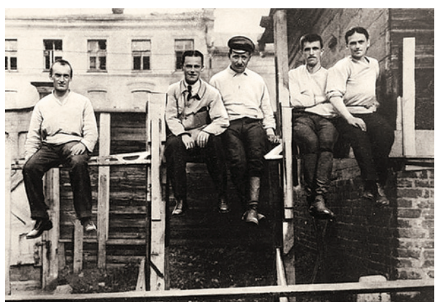
Испытания лонжерона крыла АНТ-1 на прочность. 1923 г.
