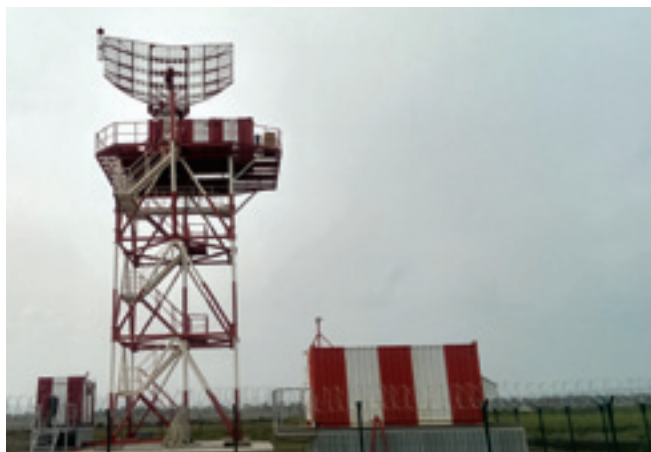
Радиолокатор АОРЛ-1АС на а-д Итуруп введен в строй в августе 2014 года
