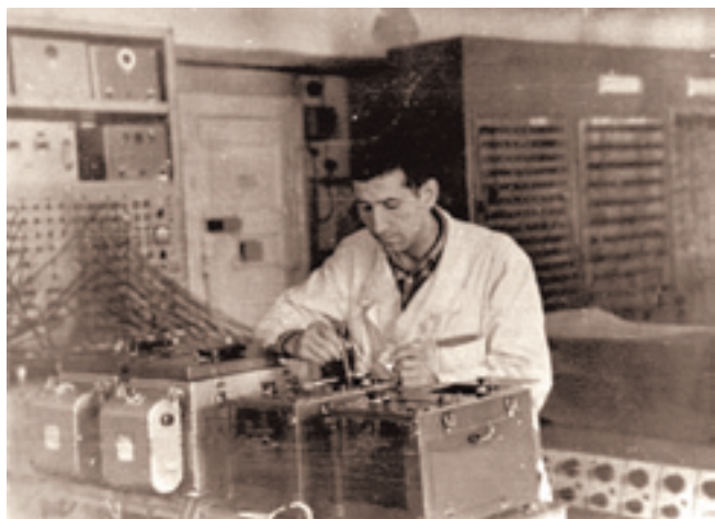
Регистрация параметров работы ЖРД при испытании, 1960-е гг.
