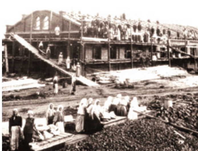
Строительство первого корпуса завода Русский Рено в Рыбинске. Лето 1916 года
