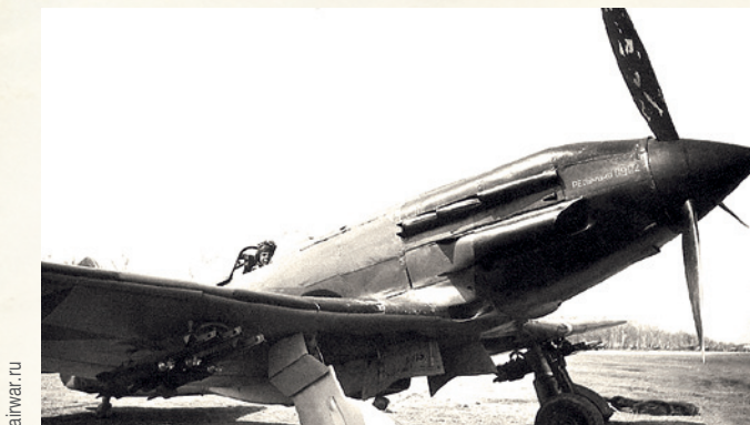
МиГ-3 №3105 с двумя строеными установками ЗРОБ-82 для РС-82
