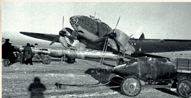
Беспарашютная мина АМГ-1 на транспортировочной тележке на фоне торпедоносца Ил-4
