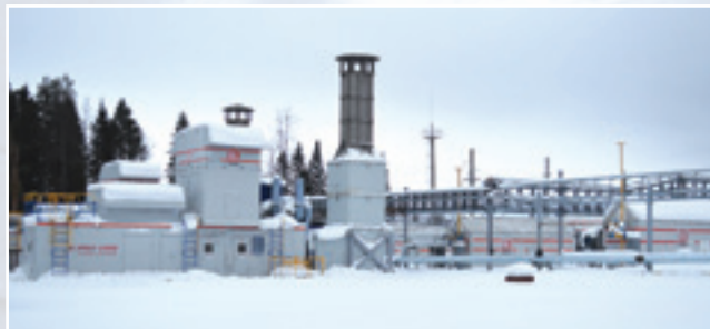
ГТЭС «Урал-4000» на Ильичевском месторождении нефти и газа
