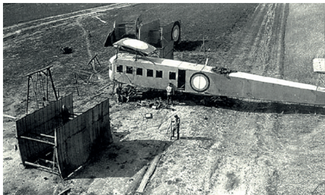
Сборка самолета «Илья Муромец» тип Б. Воздушный Корабль II
