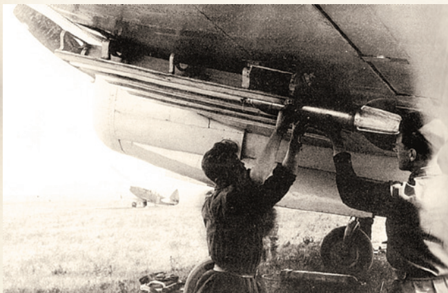
Снаряжение ракетных пусковых установок самолета СБ снарядами РС-132
