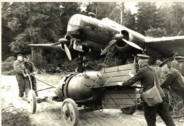
Готовится подвеска мины АМГ-1 на ДБ-3Б ВВС Балтфлота
