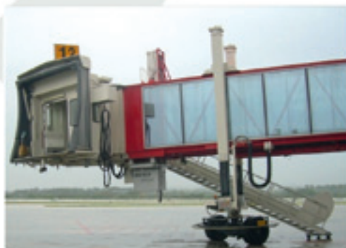
Подтрапный преобразователь 400Гц с кабельной катушкой
