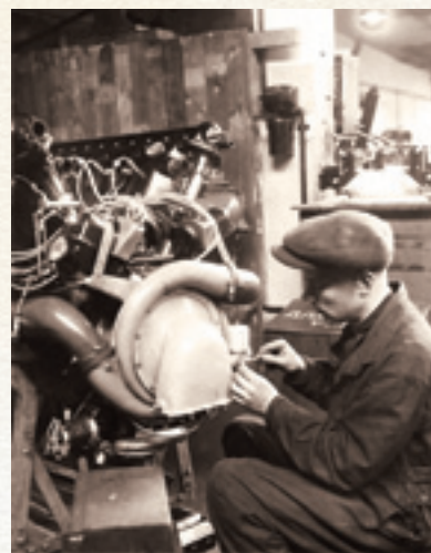
Сборка мотора М-105
