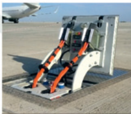
ПИТ-системы 400Гц, 50Гц, сжатый воздух, вода
