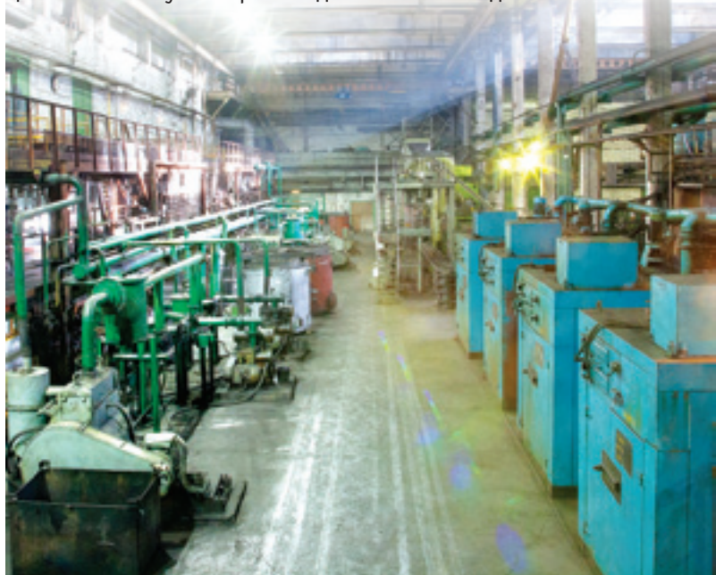
Общий вид электровакuumных печей
