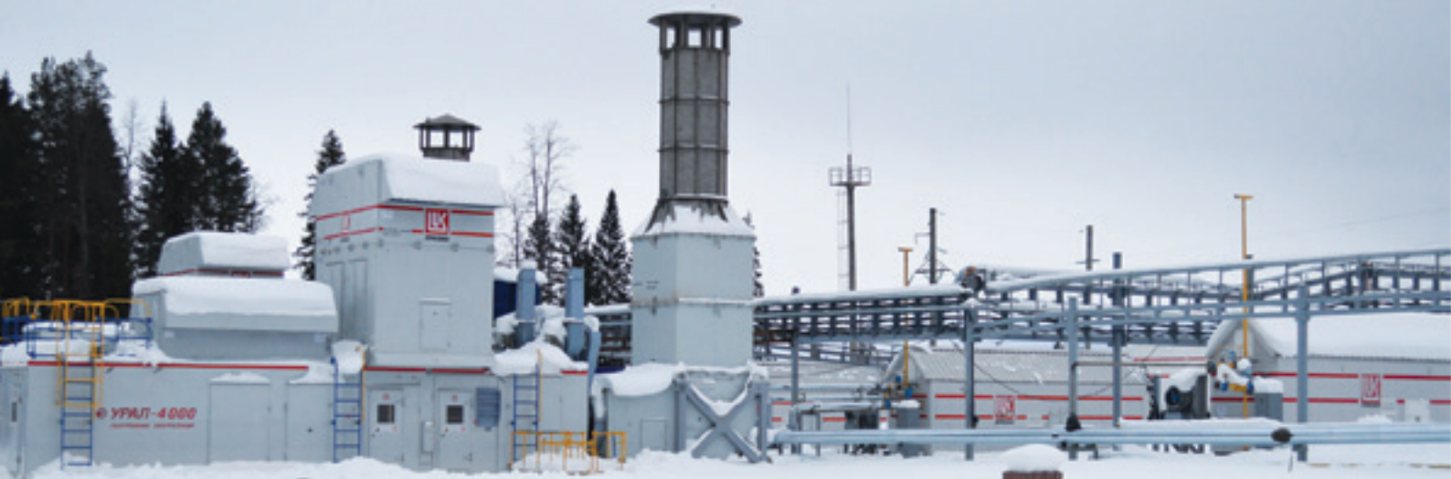
ГТЭС «Урал-4000» на Ильичевском месторождении нефти и газа
