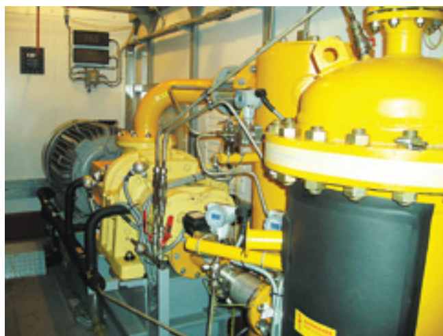
Блок подготовки топливного газа
