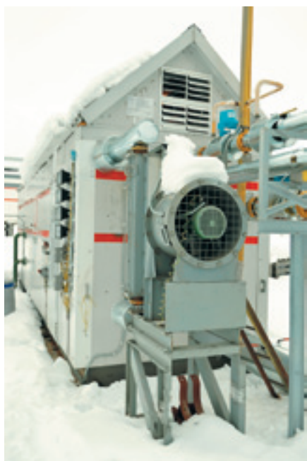
Модуль дожимной компрессорной установки
