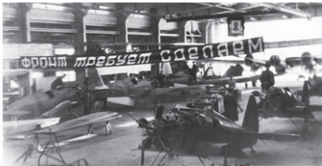
Сборка УТ-2МВ в цеху завода
