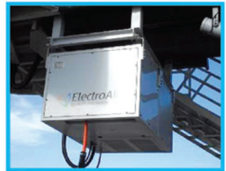
Источники питания и кабельные катушки для пассажирских телетрапов
