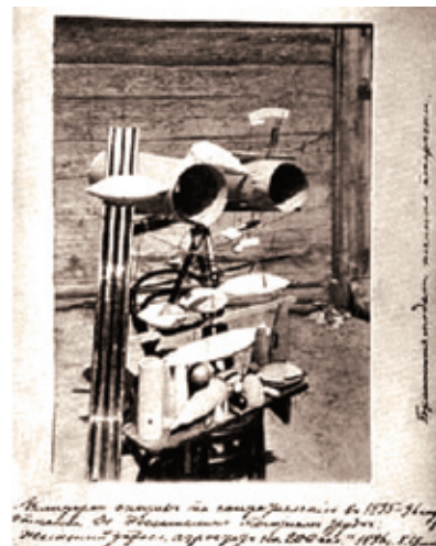
Первая конструкция аэродинамической трубы К.Э. Циолковского и испытанные в ней модели, 1896 г.
