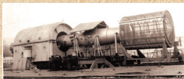
Подготовка двигателя к испытаниям на открытом стенде Ц-22, 1970-е гг.
