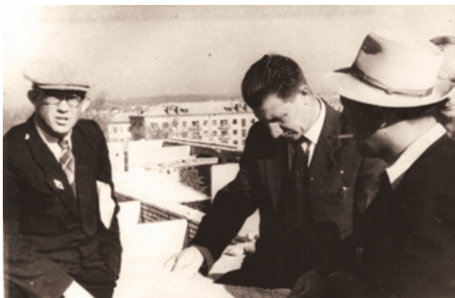
На строительной площадке
