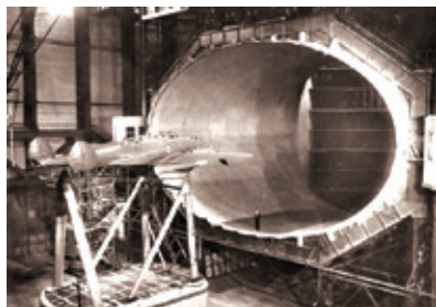
Продувка бомбардировщика СБ-1 в аэродинамической трубе Т-101. ЦАГИ, 1940 г.
