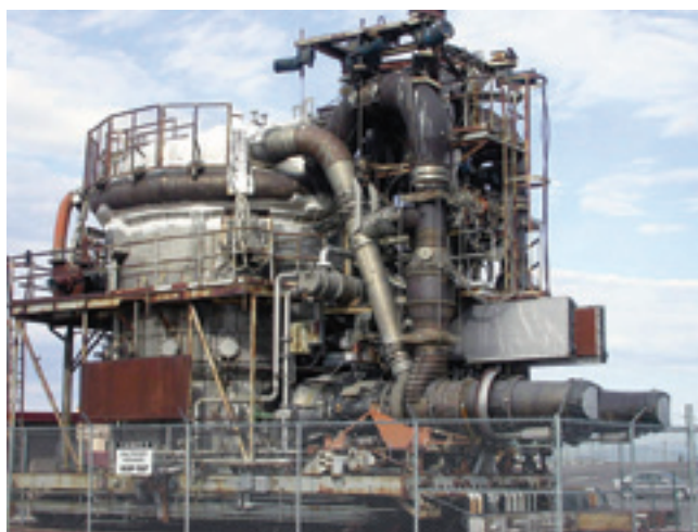
Установка HTRE-1. Левую часть снимка занимает вертикальный реактор. Снизу справа видны два реактивных двигателя. От двигателя идут две большие трубы, по которым воздух подаётся в реактор и приходит от него на турбину двигателя. Перемычка между трубами открывается в процессе запуска двигателя на керосине
