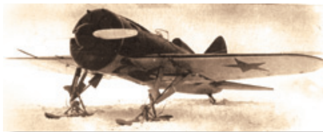
Учебно-тренировочный самолет УТИ-4 на лыжах. Зимний вариант учебного истребителя И-16
