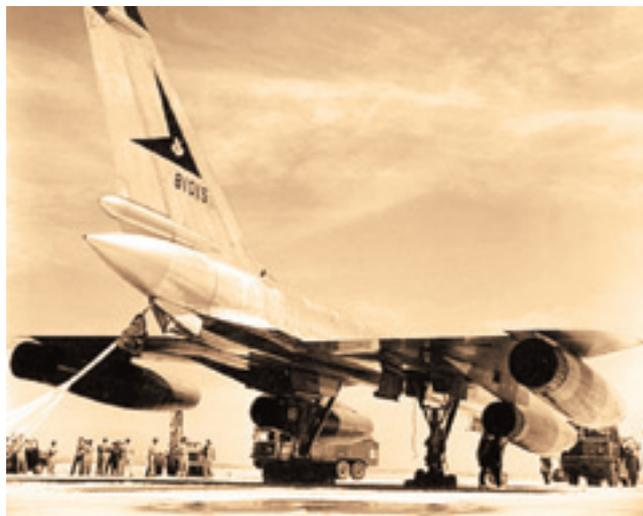
**Аварийная посадка «Хастлера» 58-1015 13 апреля 1960 года на авиабазе Эдвардс. На правой стойке пневматики сгорели. Машину спасли дополнительные стальные колеса**
