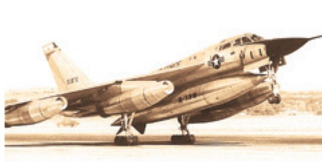
**Посадка на B-58 выполнялась с большим углом атаки. Максимально допустимый угол атаки составлял 170. Изображен 13 самолет, использовавшийся для испытаний подвесных контейнеров на авиабазе Киртланд (Kirtland). После, он был переделан в ТВ-58А**
