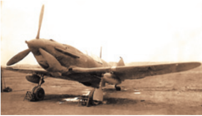
ЛаГГ-3 №213119, выпущенный заводом №31. Это один из самолетов, изготовленных для морской авиации, с подвесными баками ПБС-100, сентябрь 1941 г.
