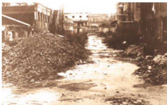
Разрушенные корпуса рыбинского завода
