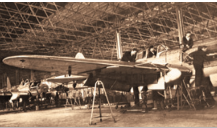
Сборка штурмовиков Ил-2 на авиазаводе № 30
