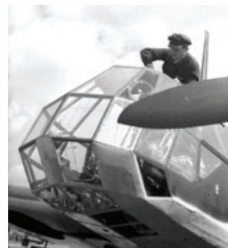
Носовой фонарь кабины пилотов. Механик обслуживает верхний люк. Огневые трубы пулемётов защиты. 1942 г.
