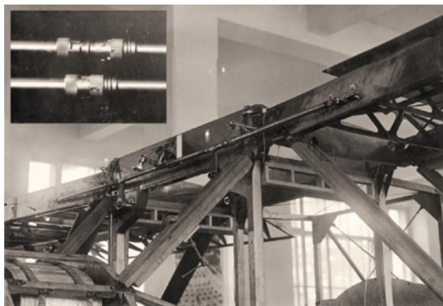
**Монтаж тяг управления элеронами и конструкция легкоразъемных замков**
