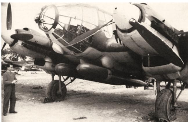
**Торпедоносец He-111Н-6 из KG26 с двумя авиационными торпедами F5b. 1941 г.**
