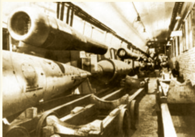
Склад готовых крылатых ракет V1 на подземном заводе Mittelwerke
