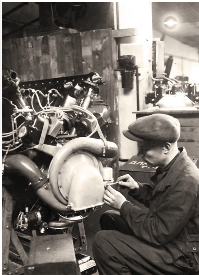
Сборка мотора М-105 в Уфе. 1942 г.
