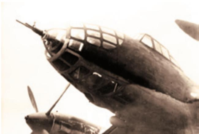
**Обильное остекление носовой части фюзеляжа Ер-2 создавало хорошие условия для ведения оборонительного огня штурманом самолета**
