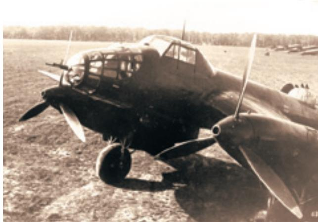
**Так называемый «спрямленный» нос бомбардировщика Ер-2 с дизелями АЧ-30Б улучшил технологию обзора для пилотов и упростил технологию изготовления машины. Носовая установка осталась прежней, а верхняя получила дополнительные элементы аэродинамической компенсации («лепестки» на прозрачной башне) из-за увеличенного сопротивления, создававшегося стволом пушки ШВАК**
