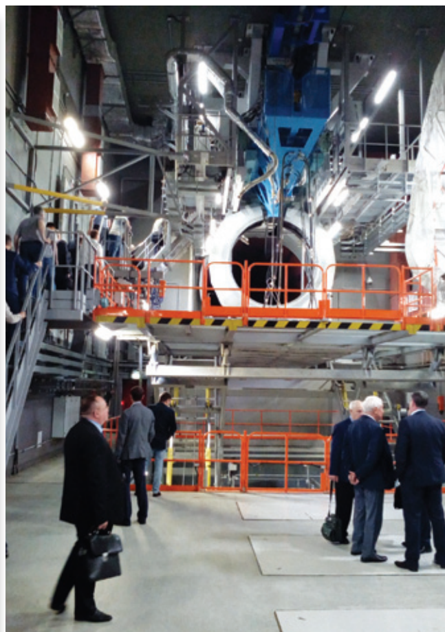
Осмотр стенда в АО «УЗГА» с СИС для двигателей с тягой 25 тс
