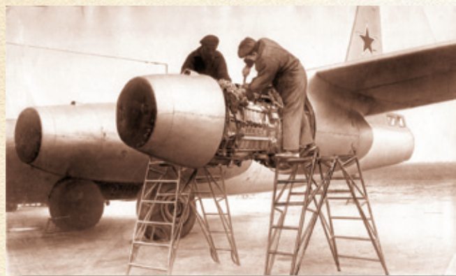
Двигатель ТР-1 на самолете Ил-22
