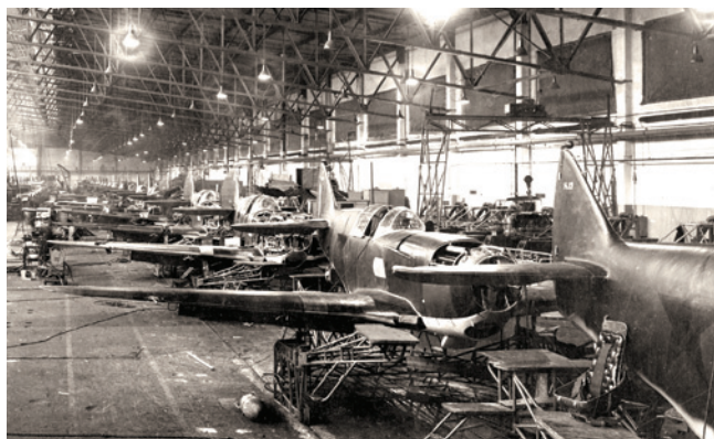
Сборка самолетов ЛаГГ-3 на авиационном заводе № 21
