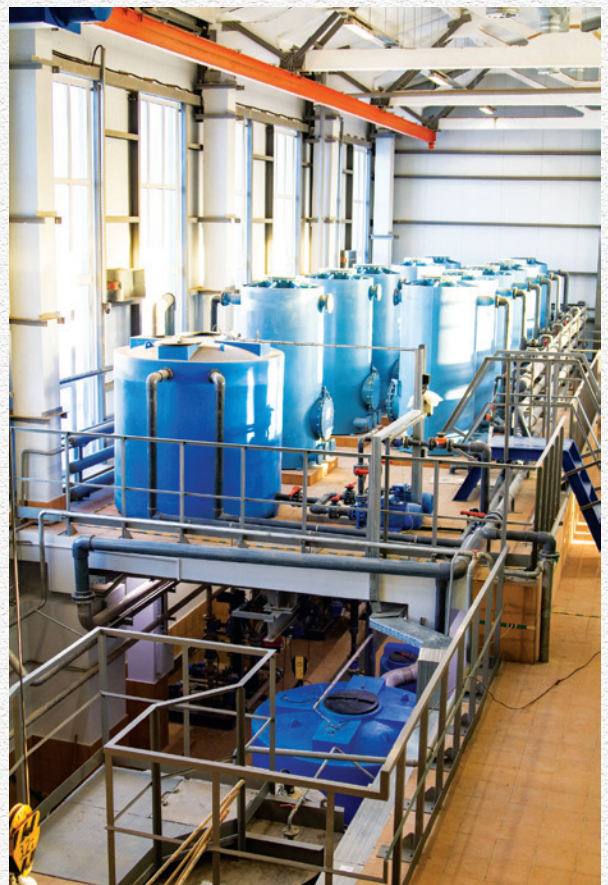
Современные очистные сооружения
