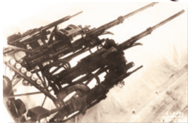
Носовая батарея оружия «сотки» на общем лафете: две пушки ШВАК и два пулемета ШКАС
