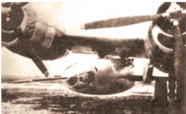
Самолет «346» подвешен между моторами самолета-носителя В-29
