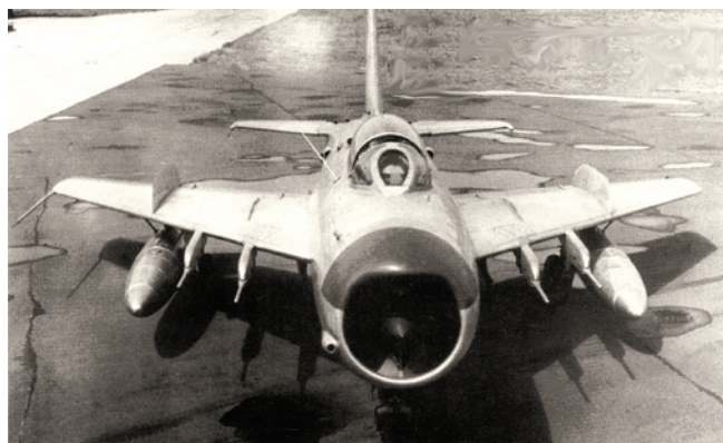
МиГ-19ПМ вид спереди. Хорошо видны четыре пилон с балками АПУ-4 для ракет РС-2У (К-5М), выступающие за переднюю кромку крыла. Эта версия была вооружена только управляемыми ракетами
