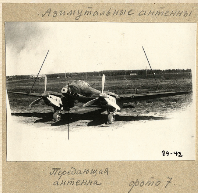
Самолёт Пе-3 с радиолокатором «Гнейс-2»
