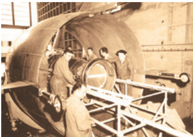
Установка двигателя в фюзеляж самолета С.450
