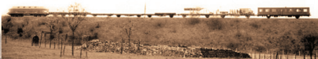
Испытания стенда С.400 P.3 на железной дороге
