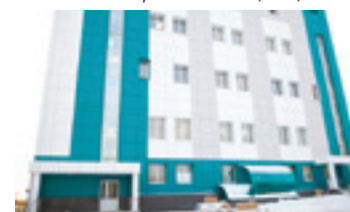
Корпус монтажно-сборочного цеха
