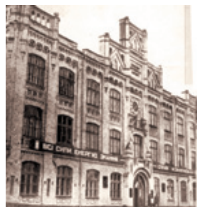
Киевский политехнический институт. Здесь с 1927 по 1931 гг. учился А.М. Люлька
