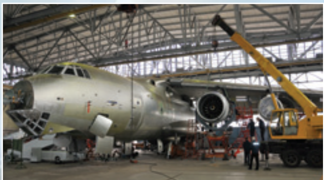
Процесс монтажа двигателя ПД-14 на Ил-76ЛЛ №0807
