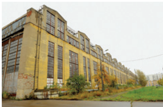
Цех окончательной сборки завода №1 имени Авиахим, 1930-е
