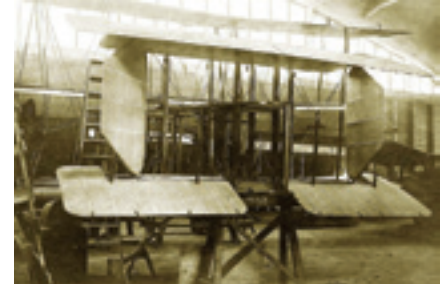
Ангар №7. Сборка триплана «КОМТА» 1921 г. Из архива В. Л. Корвин-Кербера
