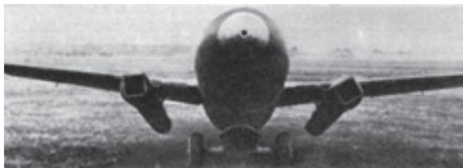
**Прототип бомбардировщика Me 328В-0. Вид спереди. Видна стартовая тележка. Интересно – как сохраняются двигатели во время посадки?**
