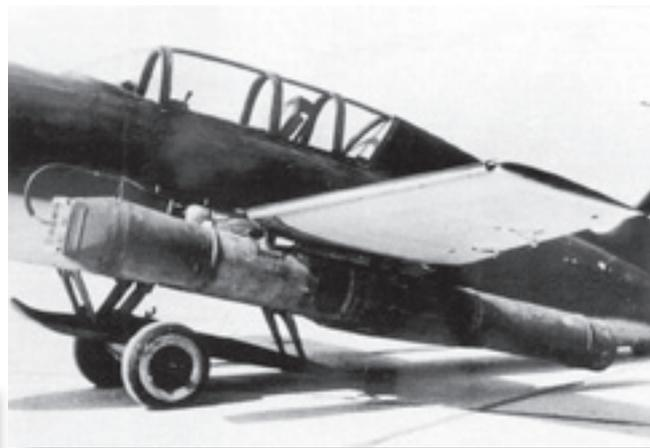
**Установка двигателя Argus As-014 под крылом прототипа бомбардировщика Me-328 B. Самолёт стоит на стартовой тележке, предкрылок выпущен. Воздухозаборник двигателя не устанавливался**
