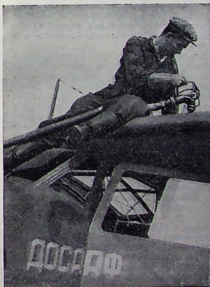
Все регламентные работы авиационной техники А. Трофимов (ЦАК СССР им. В. П. Чкалова) выполняет одновременно и высококачественно. Это позволило продлить ресурс двигателя на его самолете на 25 процентов. За постоянное содержание машины в хорошем состоянии тов. Трофимов имеет ряд благодарностей и денежных поощрений. На снимке: А. Трофимов заправляет самолет горючим.
