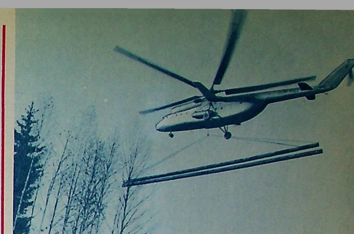
Нефтепровод Шаим — Тюмень, что в Тюменской области, проходит по сильно заболоченным и труднодоступным районам тайги. Здесь для подвозки труб нельзя использовать обычные виды транспорта. На помощь строителям пришел вертолет. Командир Ми-6 Юрий Южаков вместе с остальными членами экипажа организовал перевозку по воздуху стальных 35-метровых плетей. Только за один день экипаж сделал шесть рейсов, доставив строителям 350 метров труб. На снимке: Ми-6 в воздухе. Фото И. Сапожкова (ТАСС)
