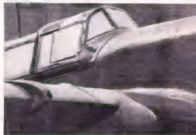
Фонарь кабины и обтекатель пушки ВЯ. Воздухозаборники карбюратора с фильтром ЦАГИ.
