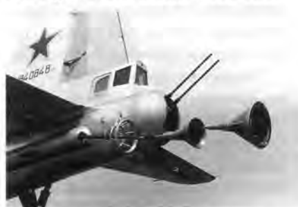
Выпуск с бомбардировщика Ту-4 №1840848 буксировочного и заправочного конусов
