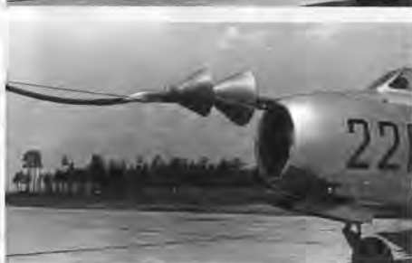
Подтягивание истребителя МиГ-15бис №2215304 и начало контактирования буксировочного и заправочного конусов
