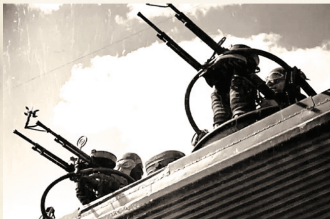
Оборонительные установки с пулеметами ДА-2 на бомбардировщике ТБ-3
