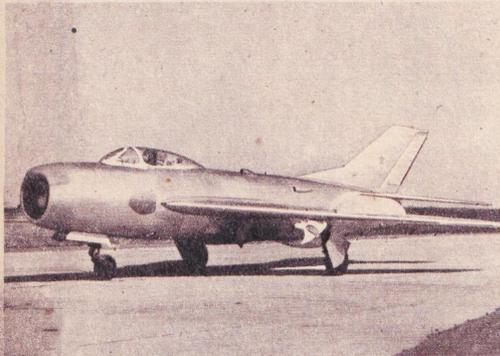
модифицированных вариантах МиГ-17, в частности, переднюю часть и крыло опытного самолета СМ-2, а хвостовую часть спроектировали заново так, чтобы разместить в ней два двигателя РД-9Б с форсажными камерами.
