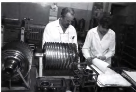
Участок сборки и балансировки роторов компрессора
