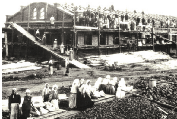
Строительство первого корпуса завода «Русский Рено» в Рыбинске, лето 1916 года
