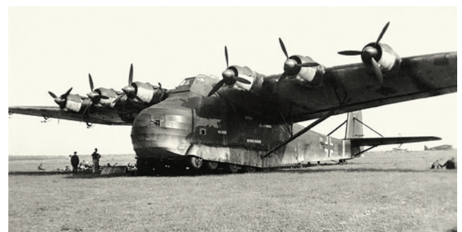
Me 323 – 6-моторный ВТС, возникший как моторизация планера Me 321
