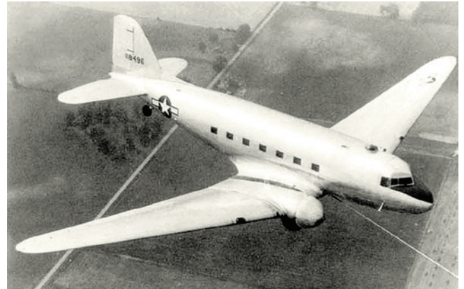
XCG-17 – переделка C-47 в десантный планер
