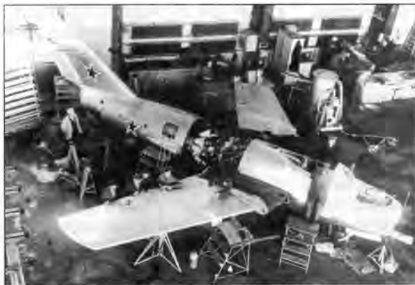
Доработка самолета МиГ-15 №101003 (СВ) в опытном производстве ОКБ-155
