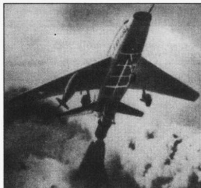
«Супер Сейбр» взлетает с помощью порохового ракетного ускорителя.
