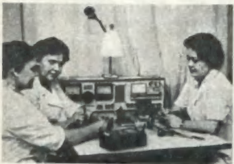
* С помощью контрольной аппаратуры проверяется вся электропроводка самолета. За столом (слева направо) электро-механики Т. Квитко, Н. Фаустова, Т. Придвизникова.
