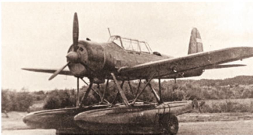
**Гидросамолет Арадо-196 с отечественным двигателем АШ-62ИР**
