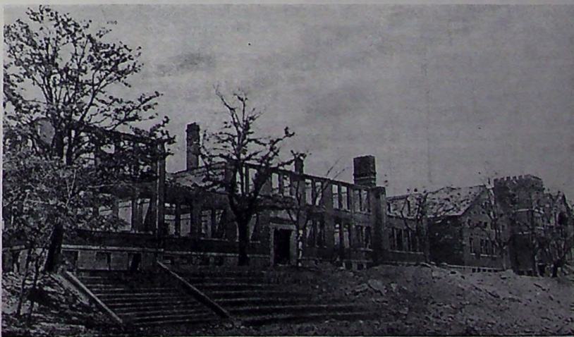
Здание средней школы в Пхеньяне, разрушенное американской авиацией.
