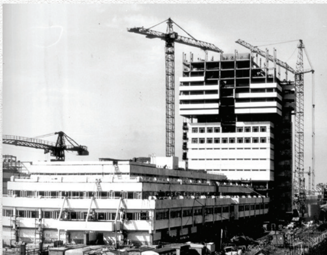
Строительство 45-го корпуса – главного административного здания.
