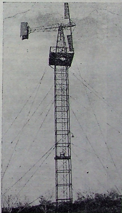
Ветряк Ветчинкина—Уфимцева, построенный в 1928 г. в г. Курске и безаварийно работающий до настоящего времени.
